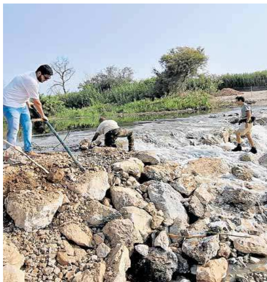
Ciudadanos dismantelan el paso de piedra habilitado para la maquinaria de la depuradora sobre el río Guadalhorce. J. R. C.
